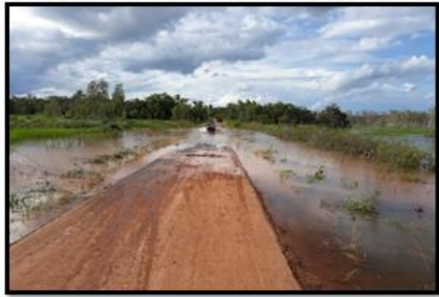
Gambar 4. Lokasi investigasi pada KM 144+300 – KM 144+700 dengan panjang 400 meter
