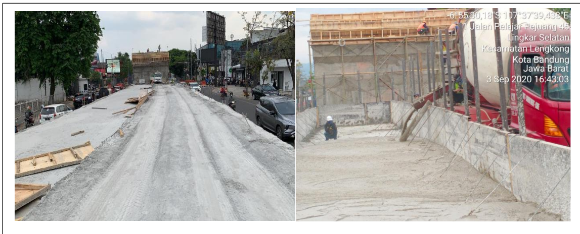
Gambar 2. Hambaran Struktur Beton LCC Pada Pekerjaan Pendekat
