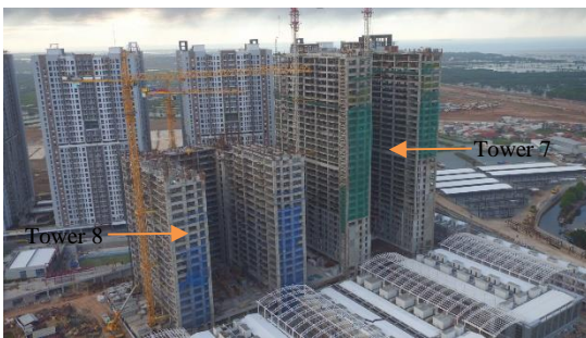
Gambar 3. Gambar Pembangunan Tower 7 Apartemen Tokyo Riverside (Sumber : dokumen proyek, Oktober 2021)
